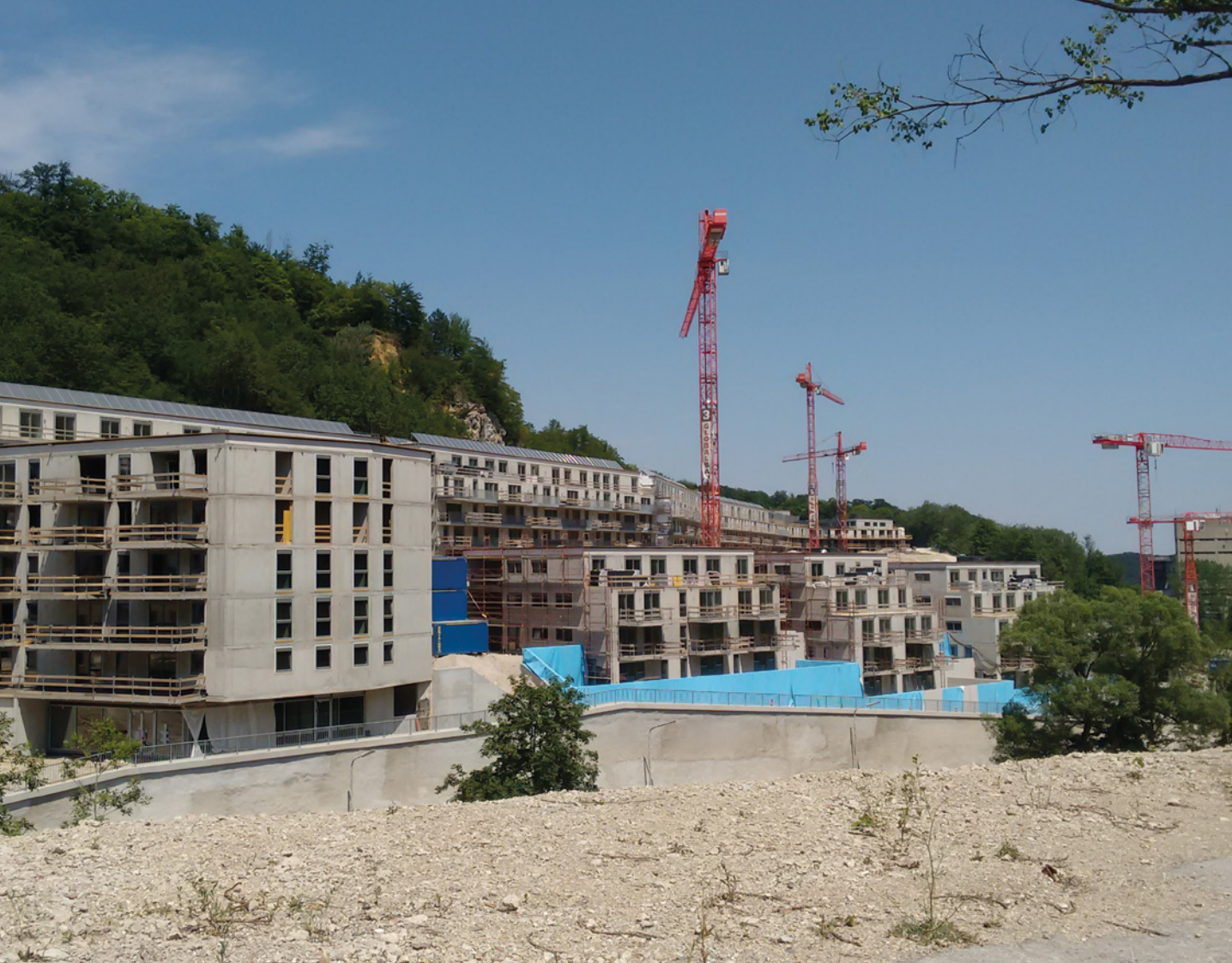
Errichtung der Wohnanlage Waldmühle Rodaun © Ailura, upload.wikimedia.org/wikipedia/commons/9/90/20150705_Wohnanlage_Waldmühle_Rodaun_133035127.jpg
